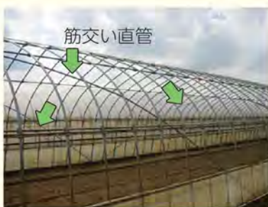
筋交いによる妻面の補強方法事例
